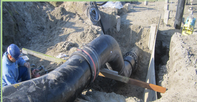
Montage de la conduite d'alimentation du clarificateur
