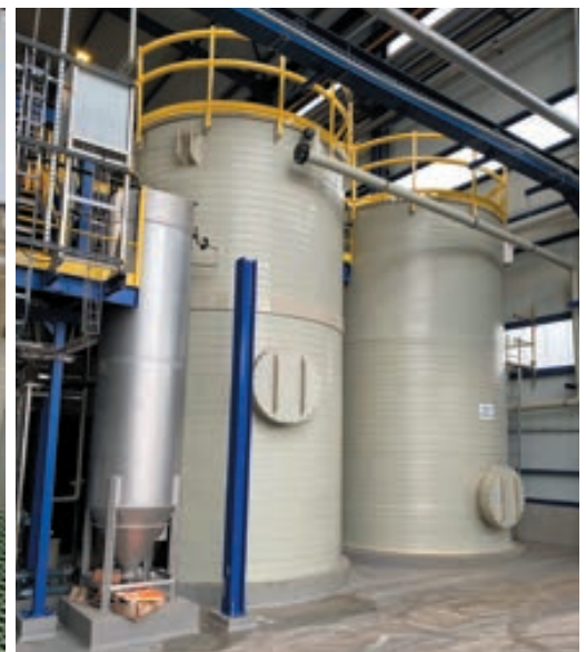
Fysicochemische behandeling (2 e trap) en zandfilter
