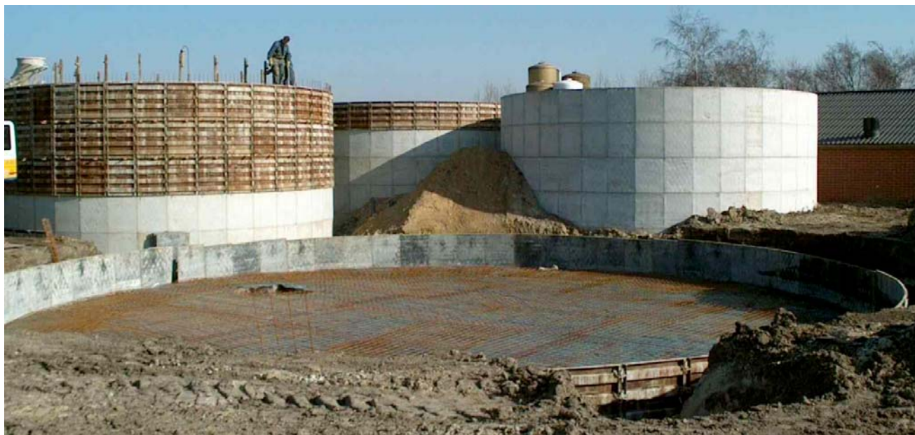
Foto: Bouwwerkzaamheden bij de mestverwerkingsinstallatie van Dhr. P. Snels
