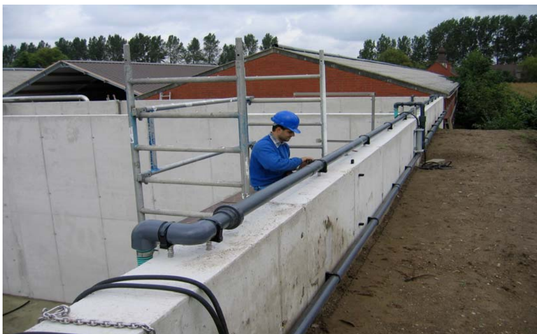
Foto: Montage van de mestverwerkingsinstallatie bij Goethals, Assenede
