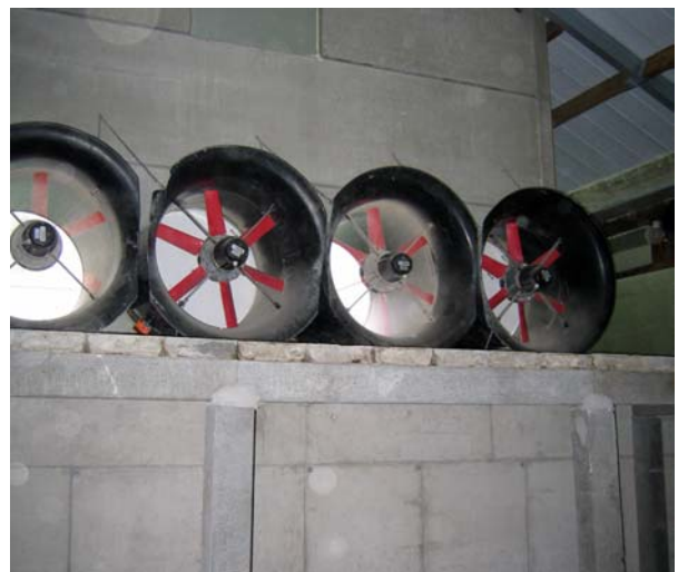
Foto: De ventilatoren worden op de waskamer gebouwd.
