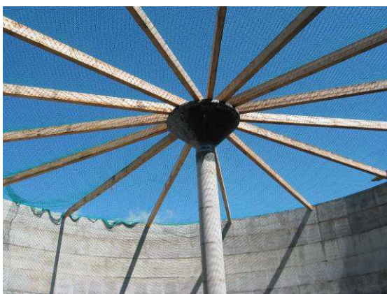
Foto: vergister in aanbouw
