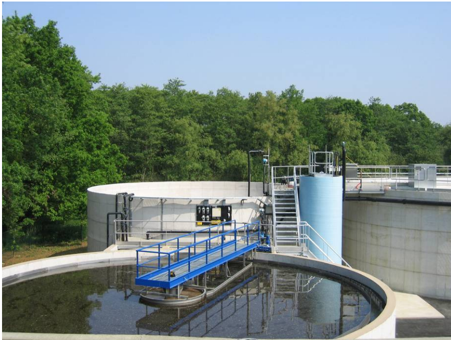
Figuur 1. Uitbreiding van de zuivering met continue nabezinker, zandfilter, slibmineralisatiebekken en rechts de gesloten extra buffertank.
