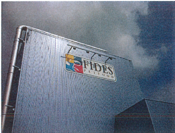
Collectorleiding vanuit drogers
