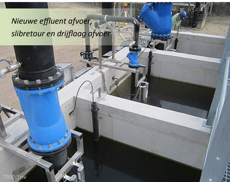
Aanleg aanvoerleiding naar nabezinker
