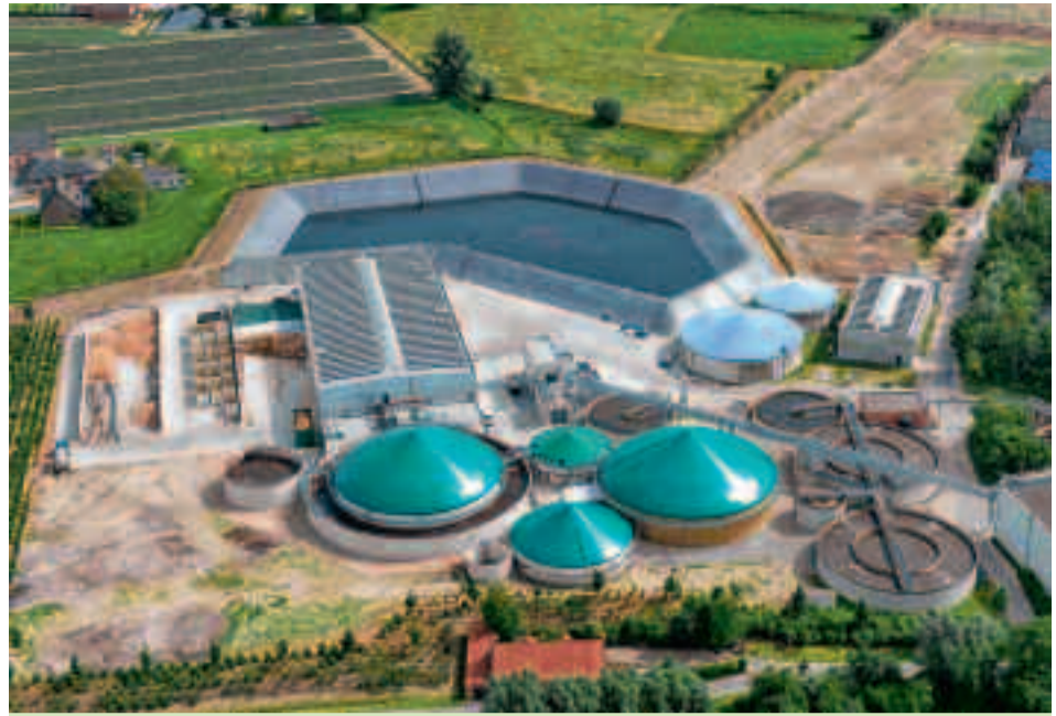
Ardo heeft in Ardoe een site van 31 met een groenzone, 5 productielijnen, 420.000 m 3 stockagecapaciteit in diepvries en een eigen waterzuivering van 600.000 m 3 /jaar. (foto: Ardo)
