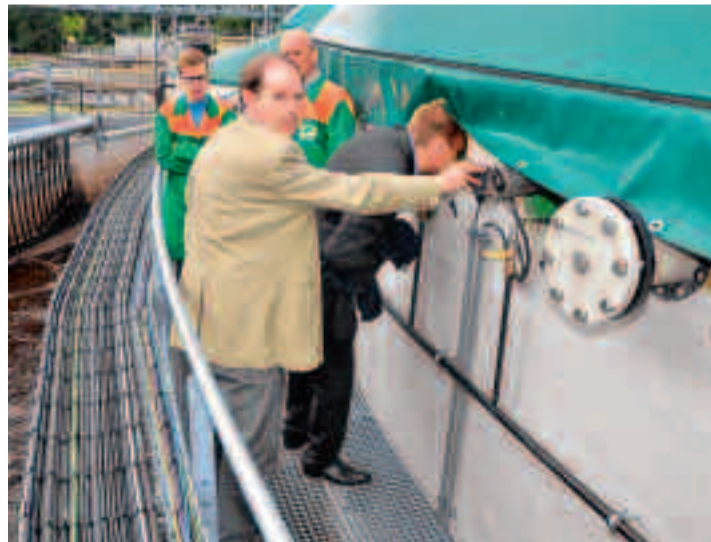
Een kijkje in de vergister. Bacteriën zetten het organisch materiaal om naar biogas dat voor 55% uit methaan bestaat. (foto: CG)
